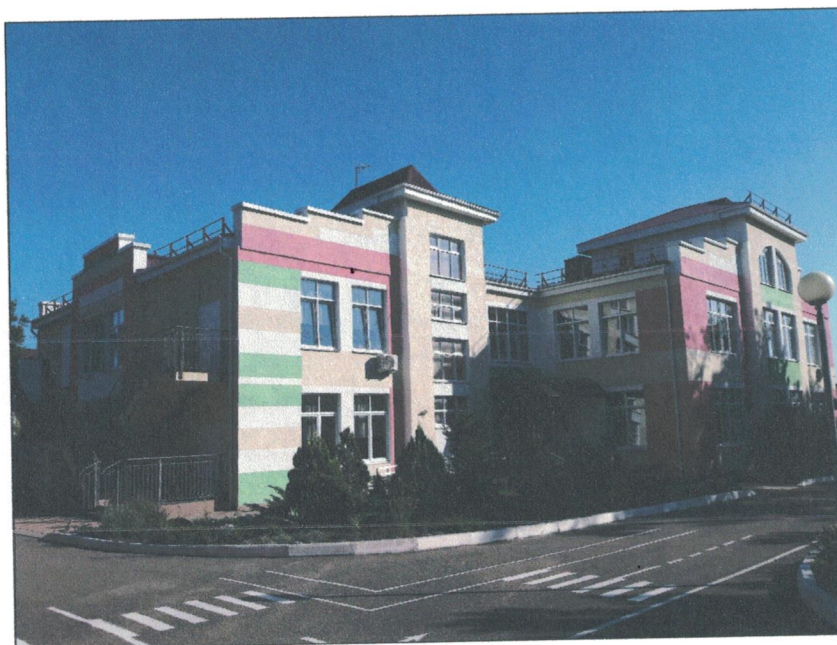
Фото 1 – Общий вид здания.
